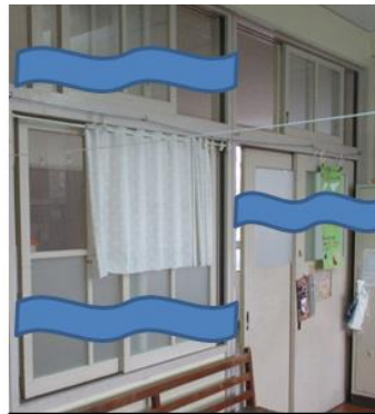
教室前後の窓を教室内での対角線状に少し開けると、風の通り道ができる。
